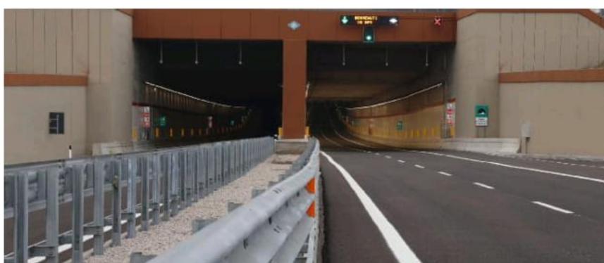
Pedemontana L'imbocco della galleria dalla parte di Malo, in direzione Montebelluna
